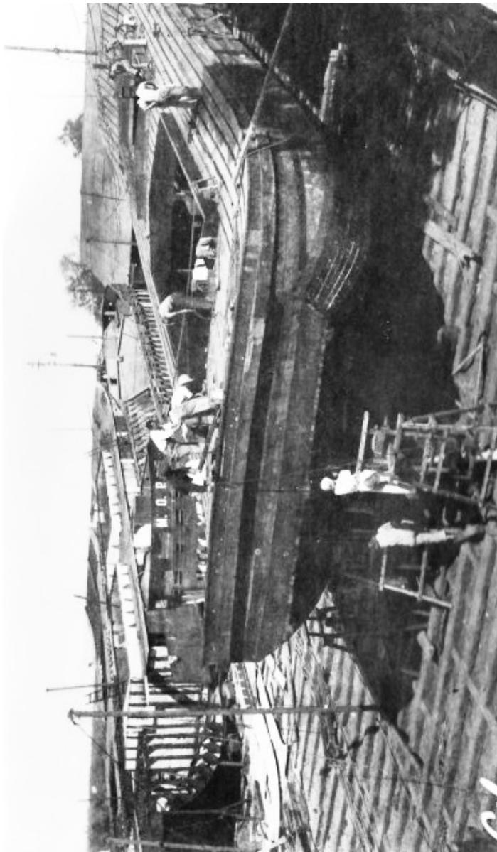
**Fotografía n° A-290-3 1.925 - Ministerio de Obras Públicas.** En su Astillero se arman Cuadernas que conforman el Esqueletode una barcaza en construcción. A la derecha, sobre el techo del Galpón, la silueta inconfundible de la Torre de las Oficinas del Ministerio de Obras Públicas, edificio ocupado actualmente por la Facultad Regional Concepción del Uruguay de la Universidad Tecnológica Nacional.
